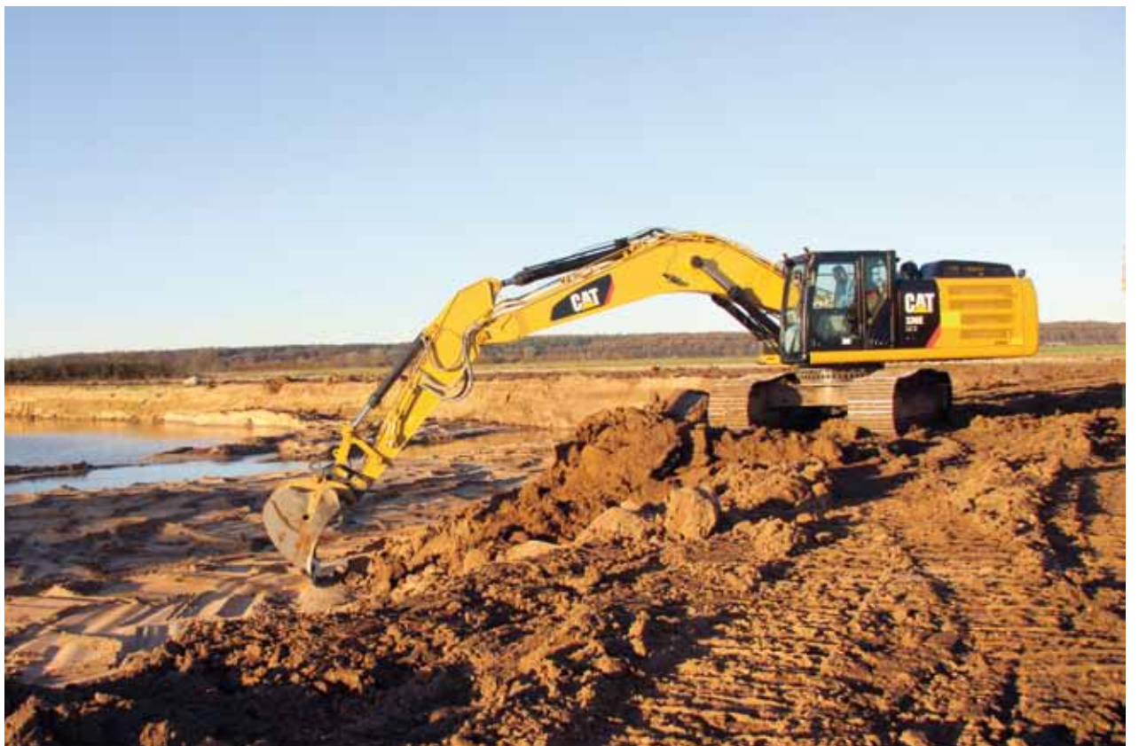
„Die Energieeinsparung können wir gezielt umsetzen, weil wir mit der Baumaschine viele Schwenkbewegungen durchführen. Und genau das ist der springende Punkt, an dem sich dann die Anschaffung rechnet“, so Thomas Lüdeke
